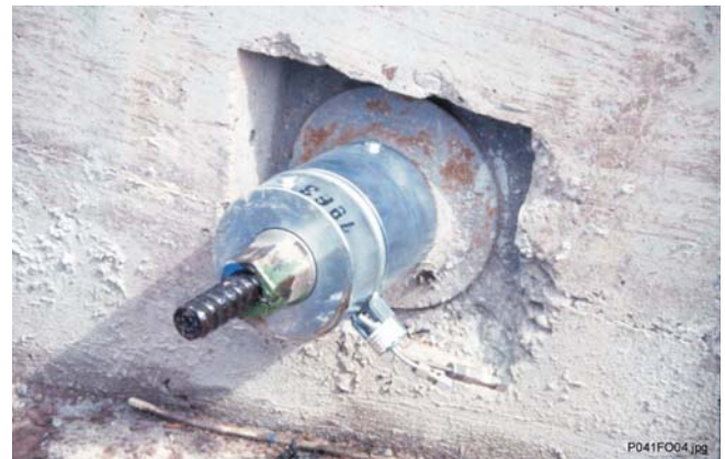
Fig.: Anclaje fijo con célula de carga
