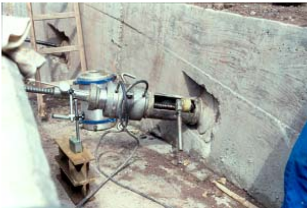
Fig.: Célula de carga para anclajes con equipo de tesado
